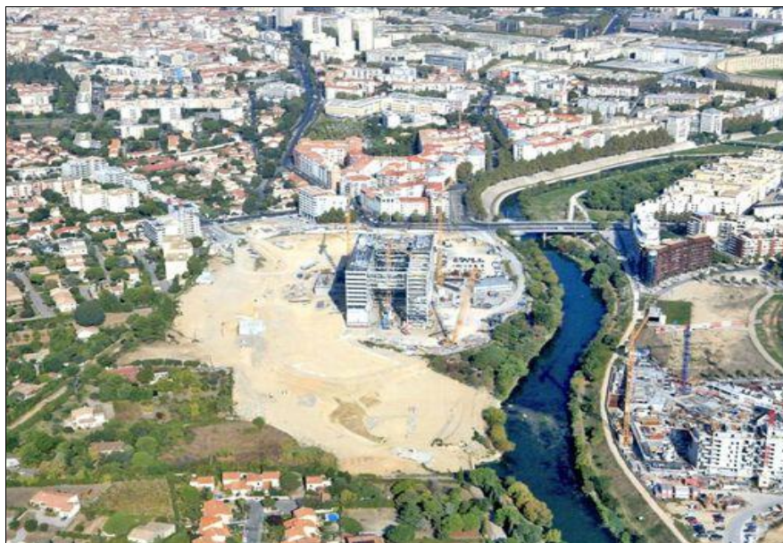
2010 - Chantier de la nouvelle mairie près du Pont Zucarelli
